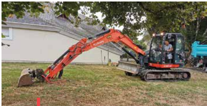
Création d'un puisard devant la Maison du Temps Libre en septembre 2022
