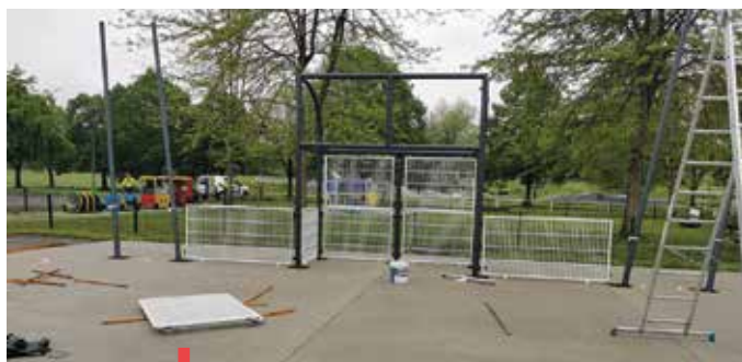
La construction du City Stade en avril-mai 2022
